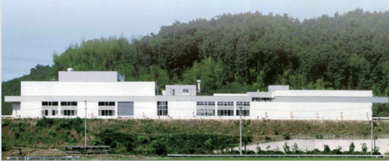
1996（平成8）年に竣工された綾部工場。別名「丹波醸房」と呼ばれ、最新設備を整えた近代的な工場味噌づくりが行われている。
