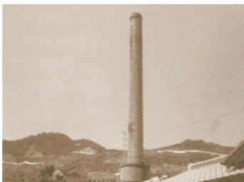
林産化学工業(株)の煙突 (和歌山県橋本市入郷)
