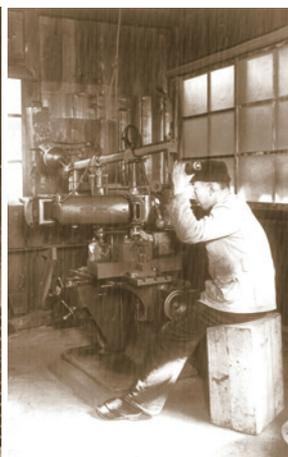
後の工具製作に使用した彫刻機(写真左) 昭和二十年頃の日本理器(株)社屋(写真右)
