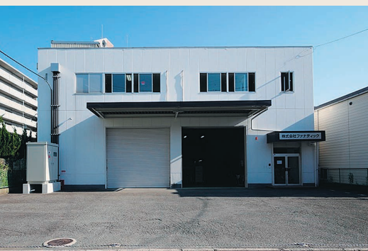
東大阪プロダクションセンター
