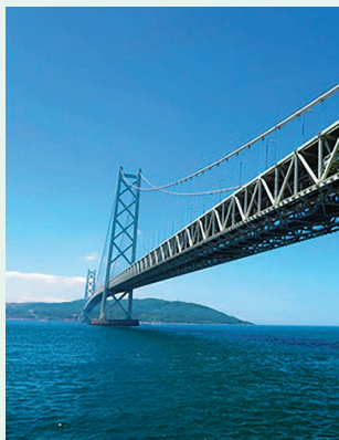
明石海峡大橋
