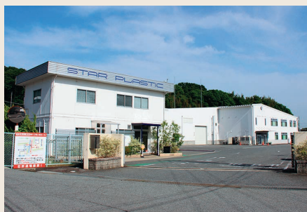
第二工場外観 （兵庫県小野市）
