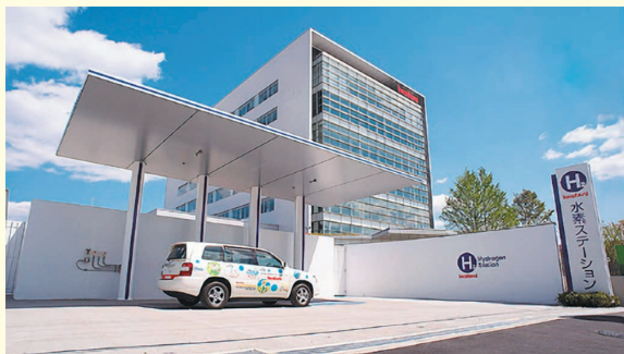
イワタニ水素ステーション尼崎(開業当時)
