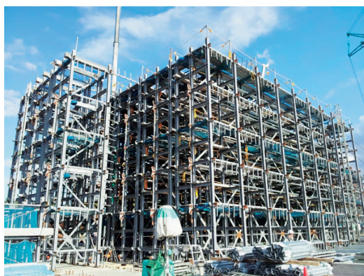
見積から図面作成、鉄骨加工を経て、現場施工まで、すべての過程の一元管理を可能にした
