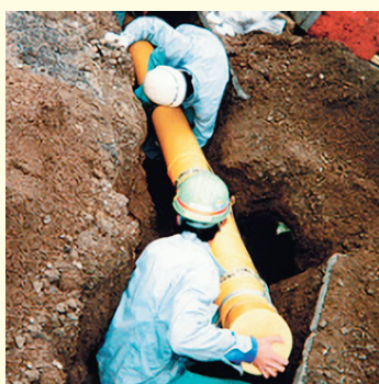
地震に強いPE管での配管
