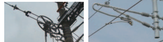
可動式プランケット(右) 滑車式自動張力調整装置(下)
