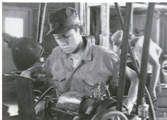
当時の作業風景
