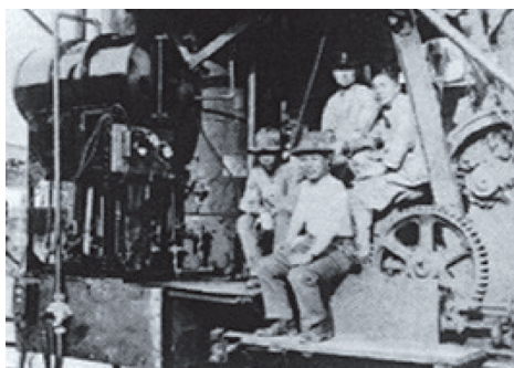
ボルカノ低圧式バーナ 試運転中の辨治(左中)
